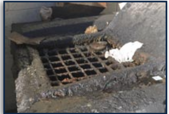
Contenedor de reciclaje de grasa en mal estado. El depósito está abierto y tiene una acumulación espesa de aceite de cocina y grasa utilizados en el exterior.
